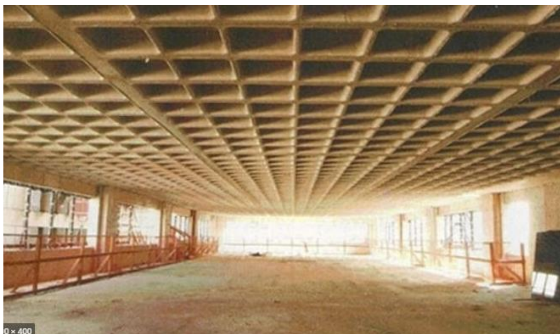
Figura 4 – Laje nervurada
